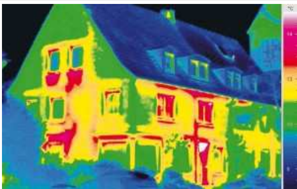
Thermografieaufnahmen zeigen Schwachstellen des Gebäudes auf, an denen viel Wärmeenergie verlorengeht. Eine erste Maßnahme, um Verbesserungen und Einsparmaßnahmen zu planen. Foto: Archiv
