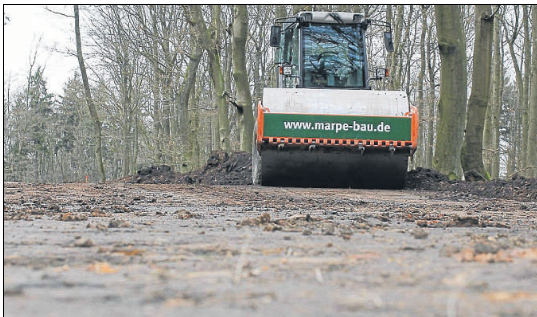
Bereits befestigt: Dieser Abschnitt des Zufahrtsweges zwischen den Rotoren 3+4 und Windrad 1 ist schon fast fertig, die Oberfläche wurde abgeschliffen.
