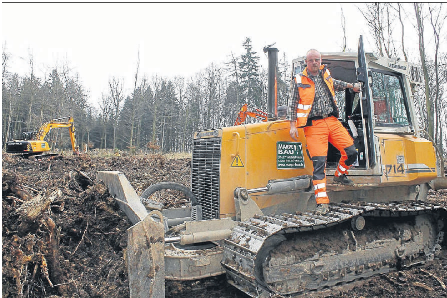
Vorbereitende Arbeiten: Mit seiner Planierraupe bewegt Baumaschinenführer Michael Steuber derzeit die Erdmassen rund um den Standort des Windrades Nummer 3 auf dem Rödeser Berg.
