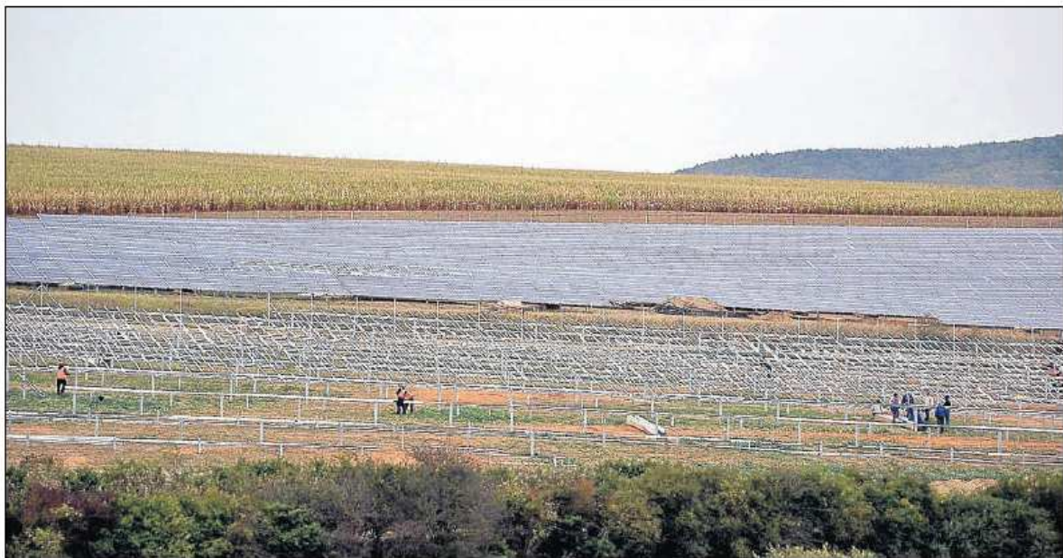
Die Arbeit läuft auf Hochtouren: Obwohl noch nicht alle Photovoltaik-Module installiert sind, soll der Bürgersolarpark noch im September teilweise ans Netz gehen.
